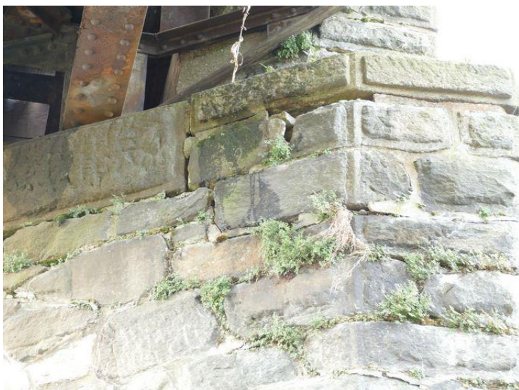
Opěra O 01: Úložný práh, vypadané spárování
