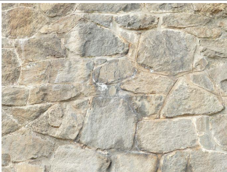
Opěra O 01: Průsaky vody s výluhy pojiva
